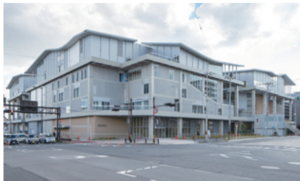
C地区 C棟北東面
