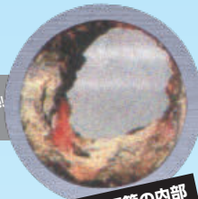
錆びた金属管の内部
